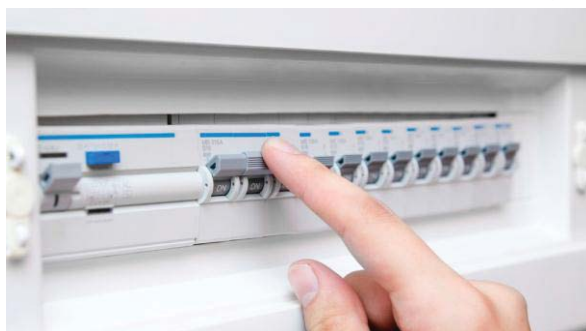
شکل ۷۵- قبل از انجام تعمیرات، اینورتر را خاموش کنید
