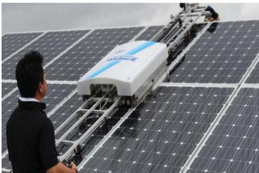
شکل ۴۴- تمیزکاری با آب با استفاده از روش روباتیک
