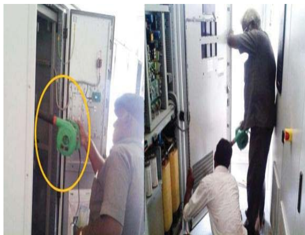
شکل ۸۹- تمیز کردن اینورتر با استفاده از دمنده
