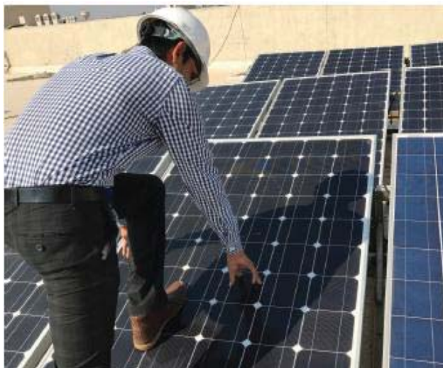
شکل ۳۹- هرگز روی مدول‌ها راه نروید
