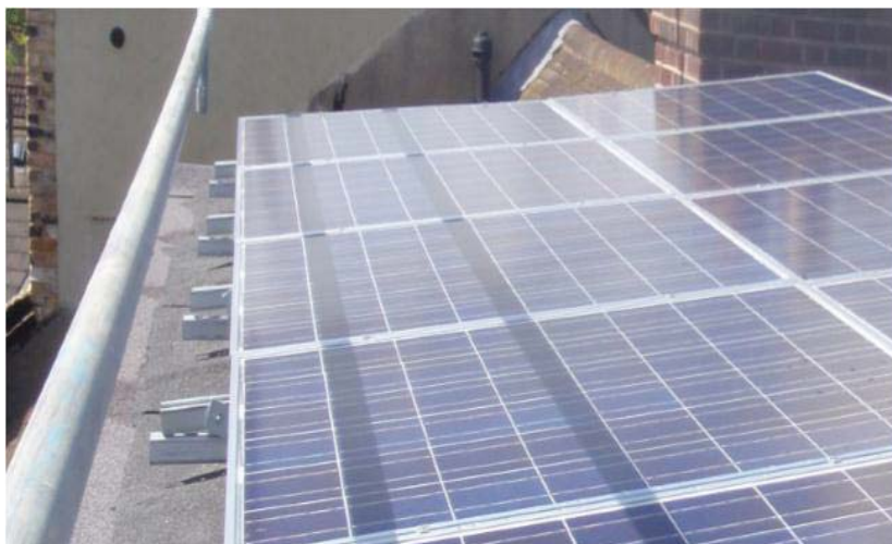
شکل ۵۱- سایه به دلیل وجود ستون‌های نزدیک در تراس (بالکن)
