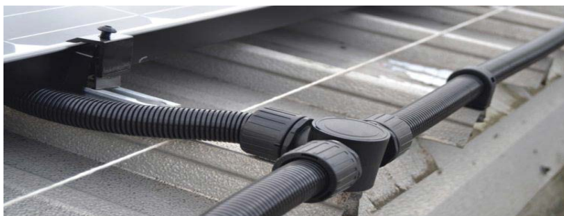
شکل ۱۱۰- نحوه صحیح عبور کاندویت
