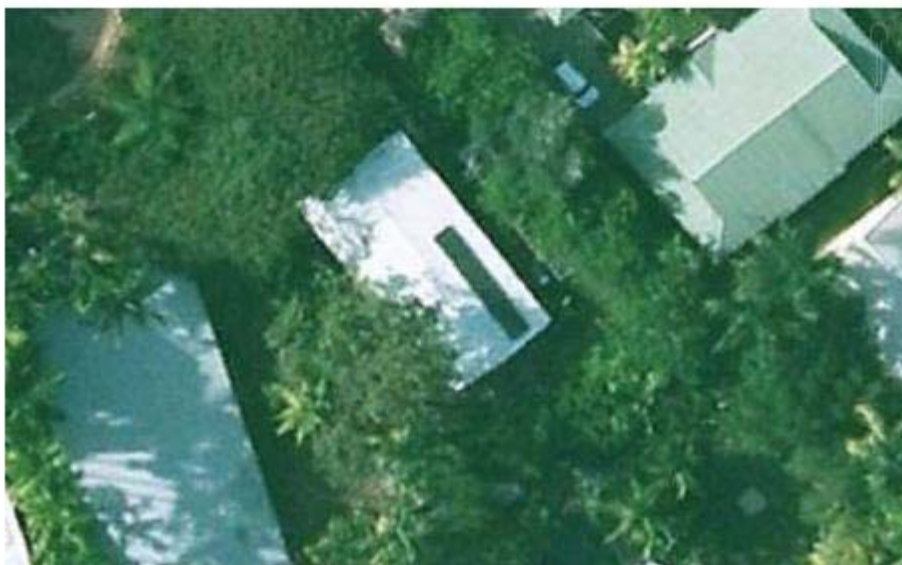
شکل ۲۹- شکل سایه جزئی بر روی سامانه نصب شده در یک ساختمان مسکونی
