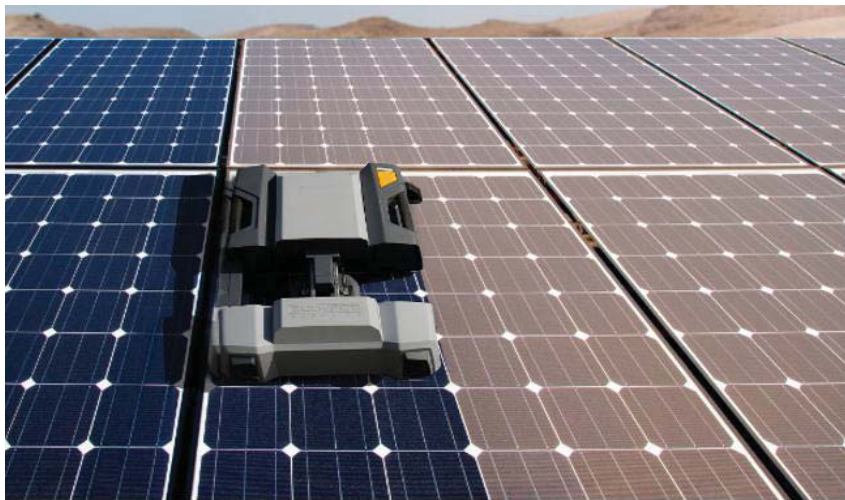
شکل ۴۶- روش تمیزکاری خشک با استفاده از سامانه خودکار
