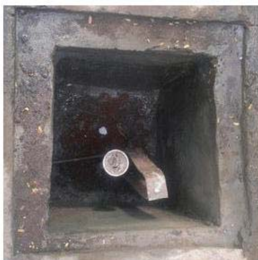
شکل ۱۶- سامانه زمین
