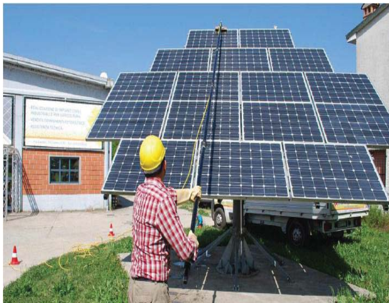
شکل ۳۷- تمیز کردن با آب (دستی)
