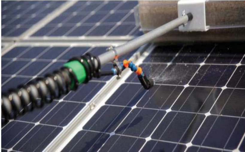
شکل ۴۵- تمیزکاری با آب با استفاده از سامانه خودکار
