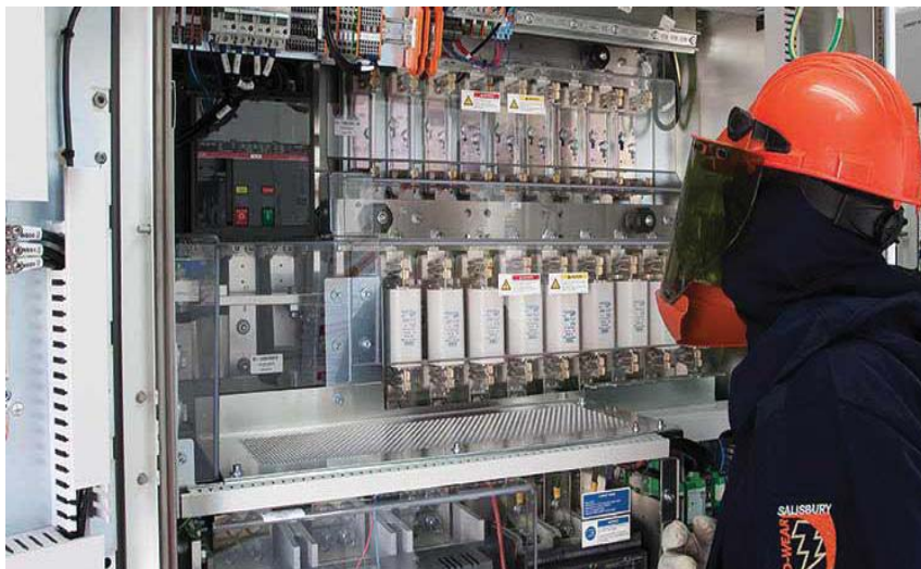
شکل ۹۲- فیوزهای اینورتر را بررسی کنید.
