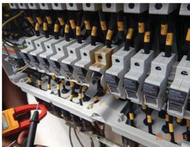
شکل ۱۳۸ - انجام آزمون توسط مولتی‌متر کلمپی
