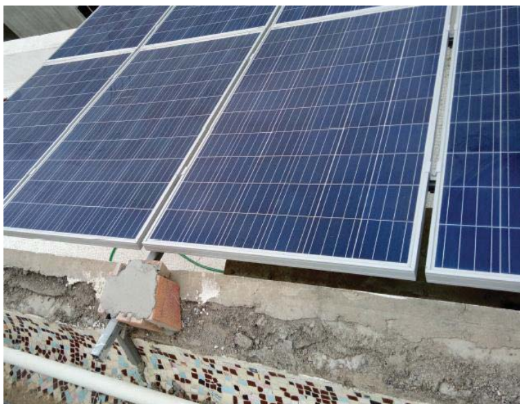
شکل ۱۱۶- نصب نامناسب
