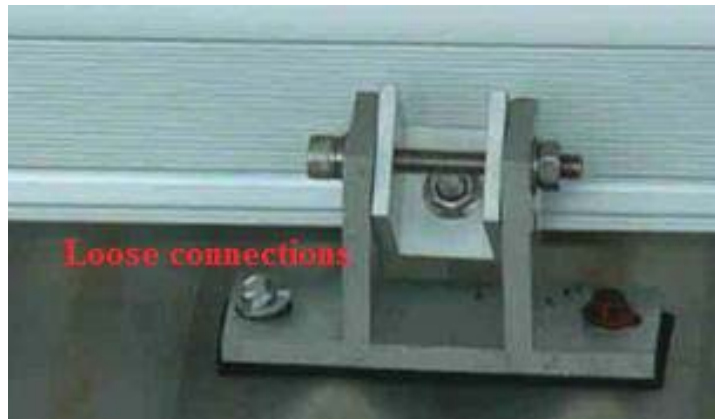
شکل ۱۱۸- کلمپ‌های شل شده
