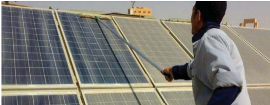
شکل ۴۲- روش تمیزکاری خشک (به صورت دستی)
